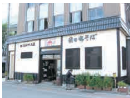
写真16 修景後の日の出そば全景
