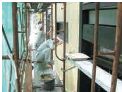
写真6 日の出そば修景塗り壁作業風景
