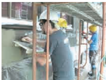
写真7 日の出そば修景塗り壁作業風景
