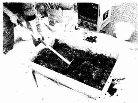
写真4 土と藁すさを混ぜる
